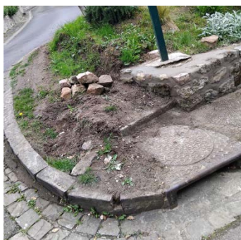
Réparation du muret Côte du Colombier
