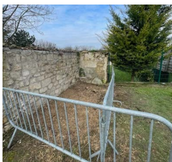
Démolition de l'abri à poules dangereux derrière l'école
