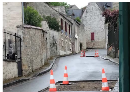
Reprise du sol rue de l'Église
